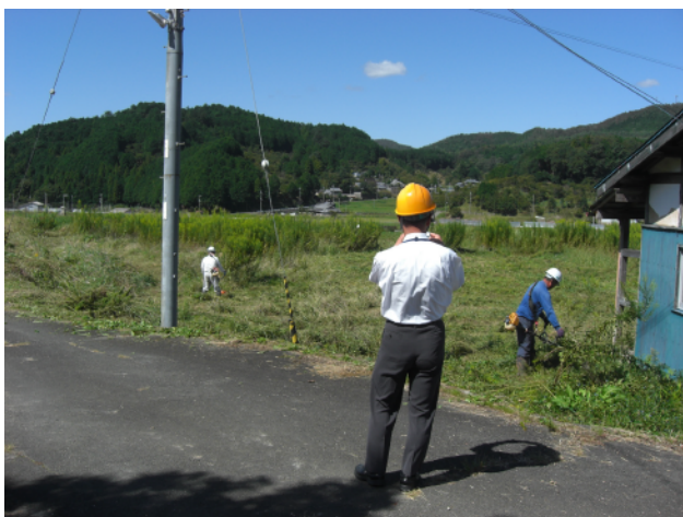
▲現場パトロールの様子
